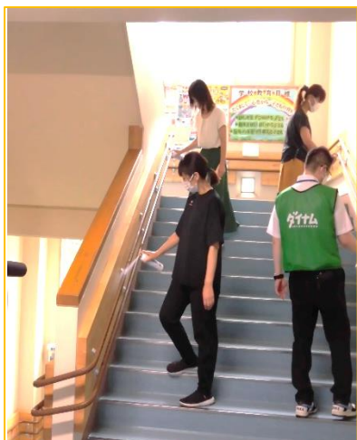
階段手すりへのコーティング
